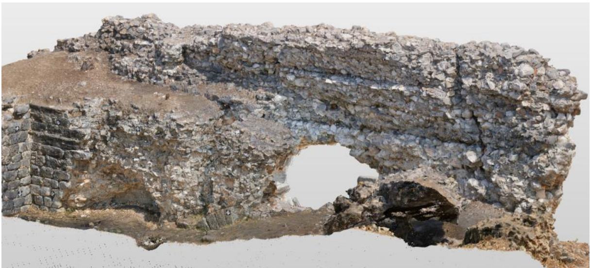
Abb. 5b 3 D-Punktwolke aus dem Innenraum, Ostmauer, Blick nach Nordosten
